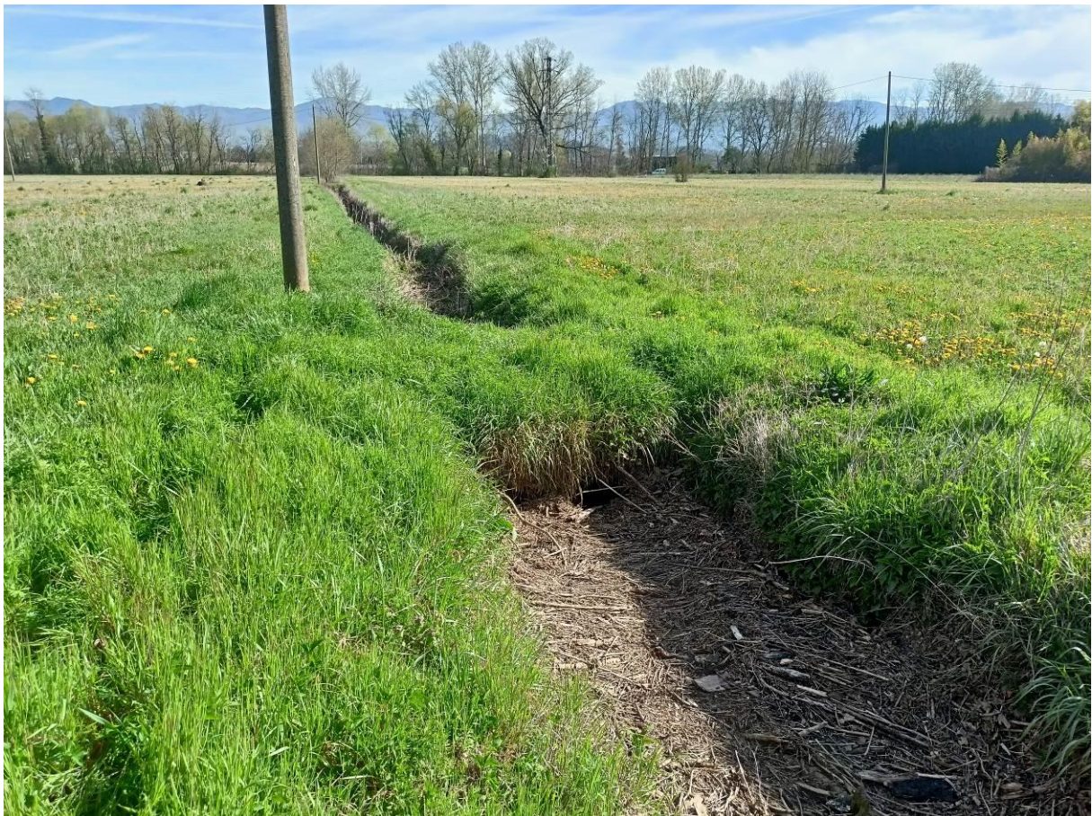
Foto 17 - Vista del fosso Romignano in corrispondenza del secondo attraversamento
