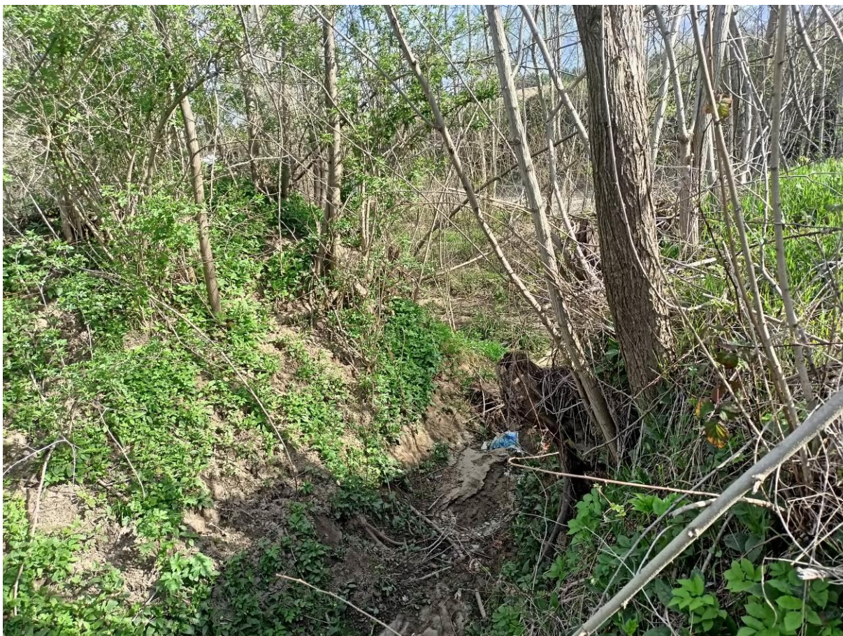
Foto 21 - Vista della sezione di sbocco nella Sieve del fosso Romignano
