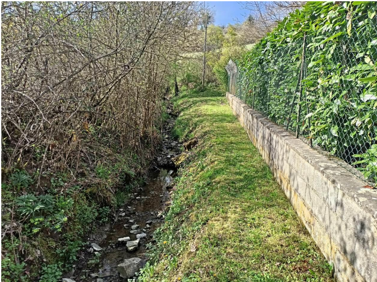
Foto 12 – Vista verso monte del fosso Romignano a monte del tratto tombato
