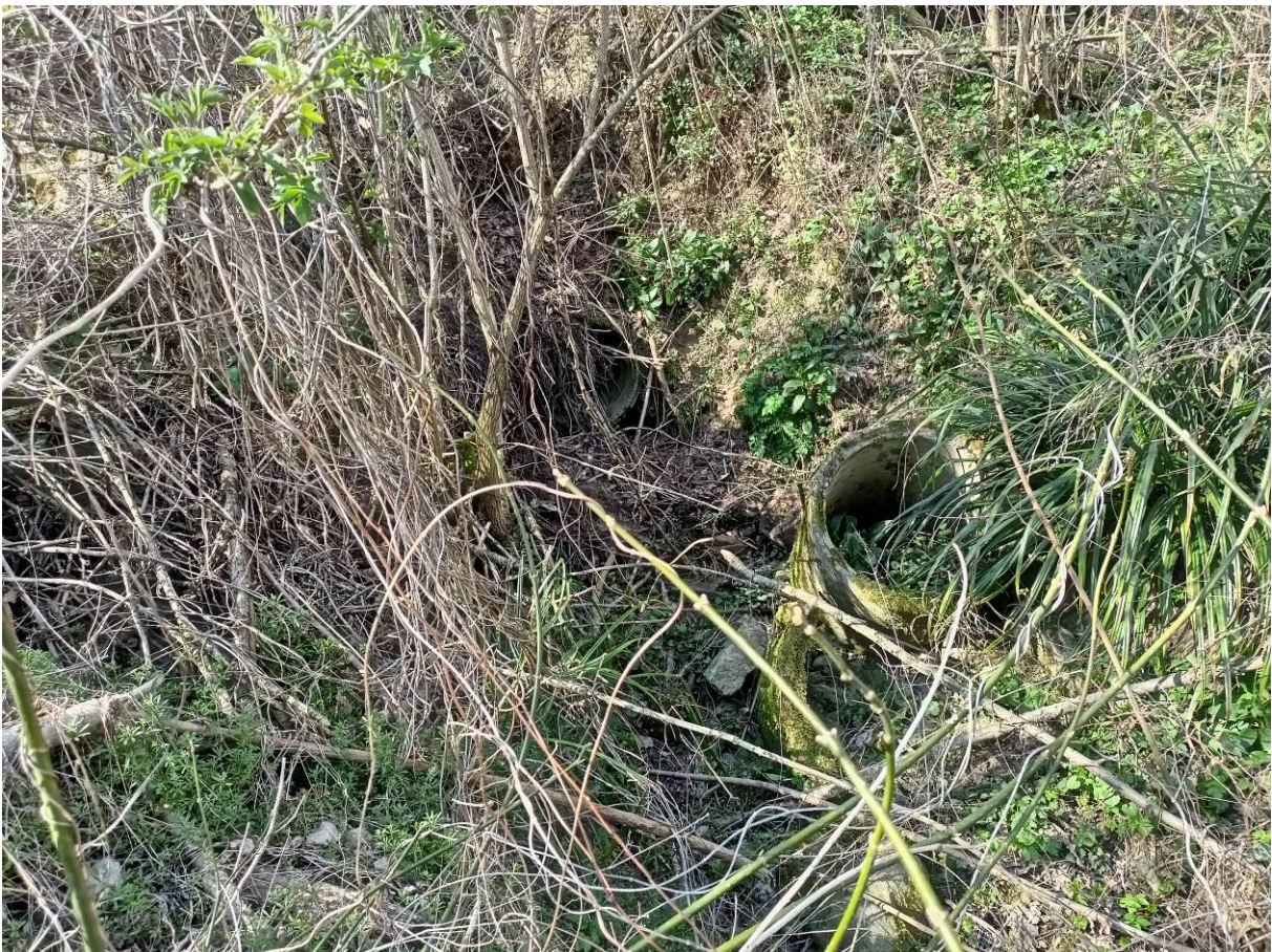
Foto 24 – Vista a fiume tubazione di scarico fosso minore di monte
