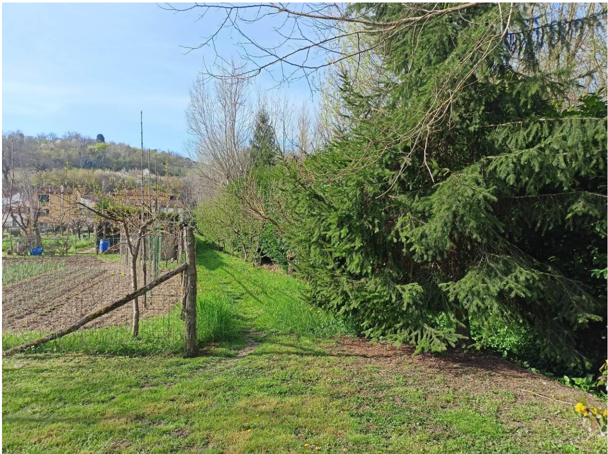
Foto 08 – Vista da valle della sponda da ringrossare del fosso Montefari
