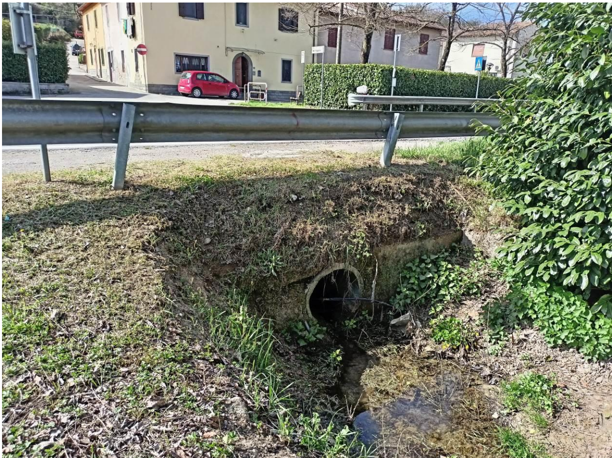
Foto 06 – Vista dello sbocco del tratto tombato del fosso Montefari
