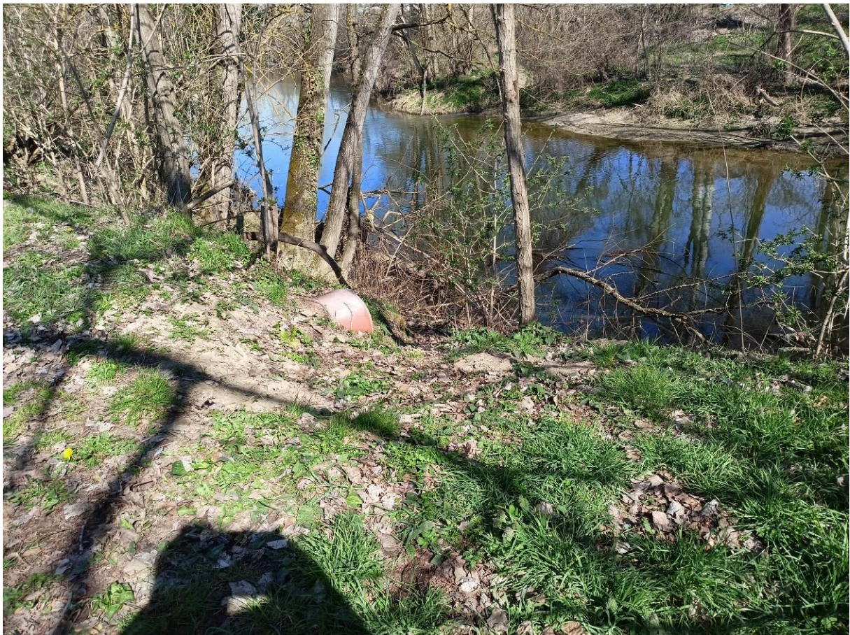
Foto 22 – Vista a fiume tubazione di scarico fosso minore di monte
