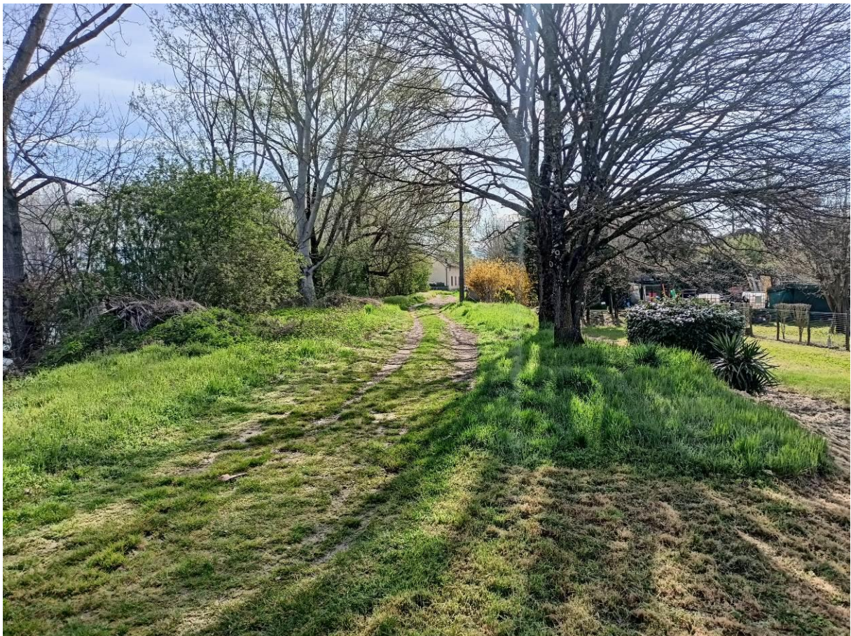
Foto 10 – Vista tratto argine Sieve oggetto di sovralzo per la messa in sicurezza al Tr 30 anni
