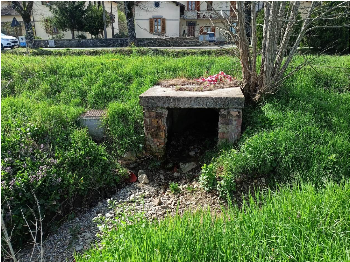
Foto 16 – Vista dello sbocco del sottoattraversamento della pubblica via del fosso Romignano
