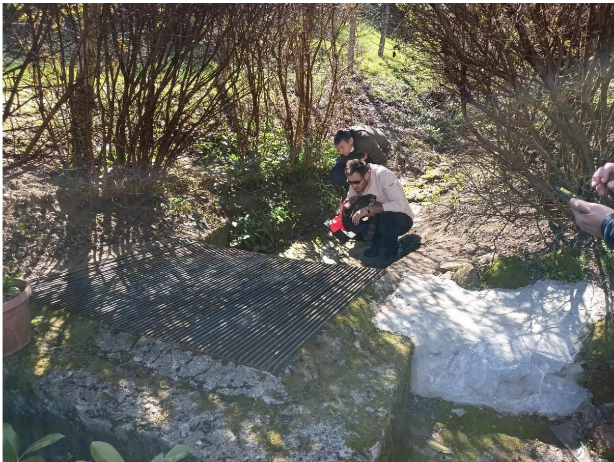
Foto 01 - Vista da valle dell'imbocco del tratto tombato del fosso Montefari
