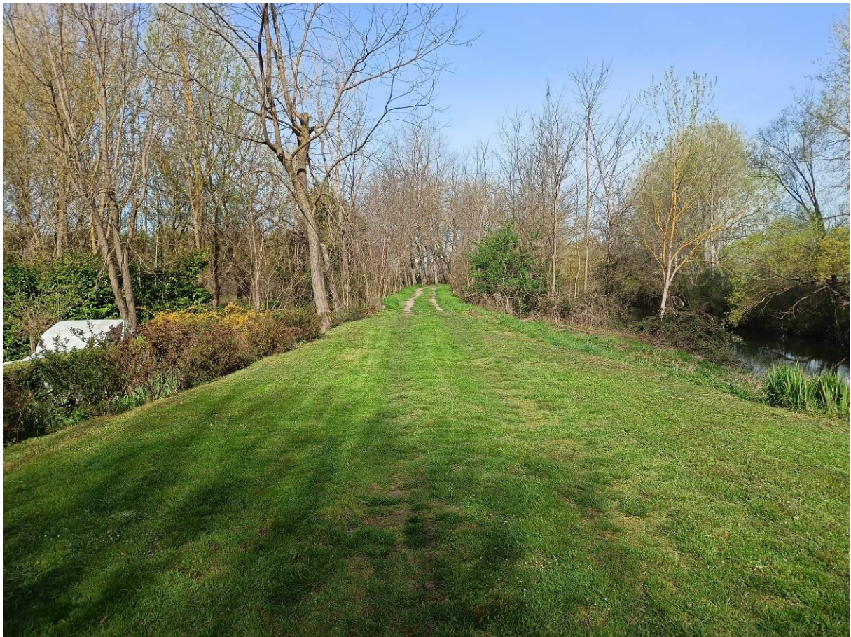
Foto 09 – Vista tratto argine Sieve oggetto di sovralzo per la messa in sicurezza al Tr 30 anni
