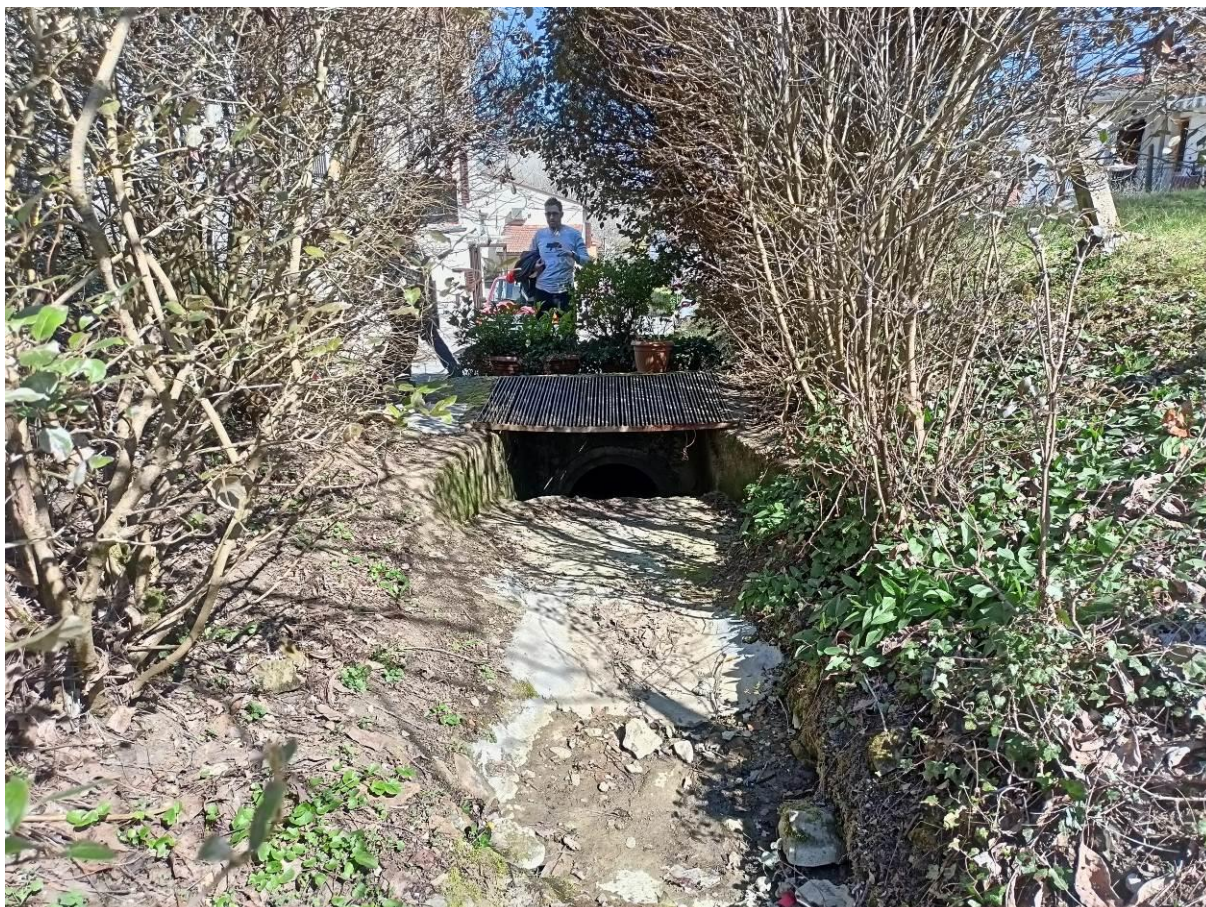
Foto 02 – Vista da monte dell'imbocco del tratto tombato del fosso Montefari
