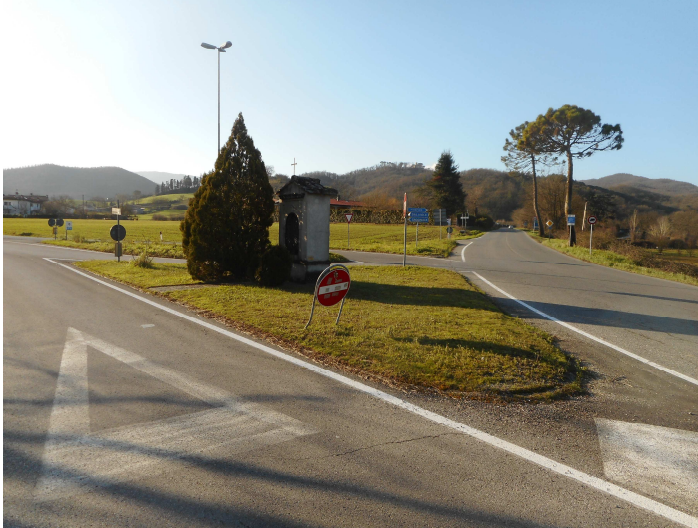
Figura 3.3 – Isola centrale dell’intersezione con tabernacolo
